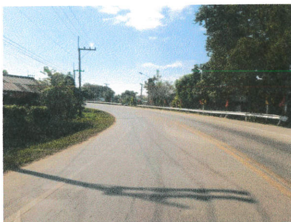
ติดตั้งบริเวณทางโค้งอันตราย หมู่ ๓ บ้านเวียงทอง พิกัด ๑๙.๙๑๖๑๑๘, ๙๙.๙๘๕๓๗๒
